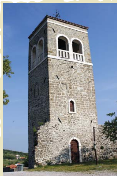
Obrambni stolp v Kubedu La torre difensiva di Kubed
